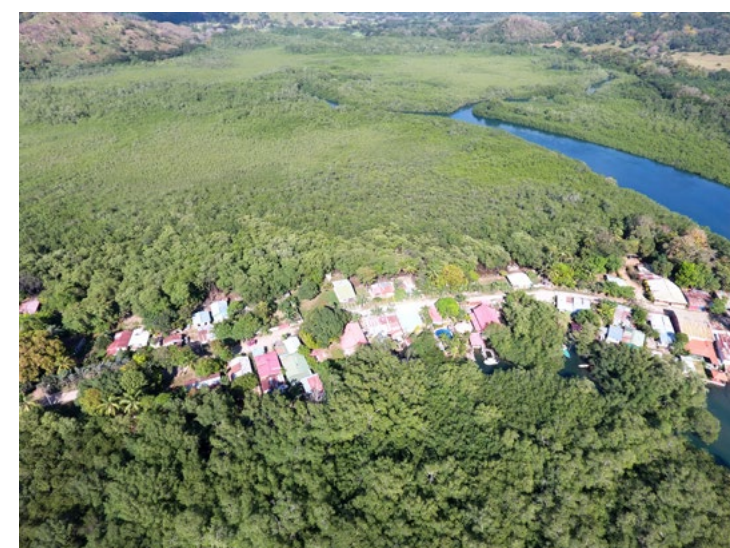
Figura 183. La comunidad de Puerto Pochote, en Bahía Ballena, se ubica a escasos centímetros sobre el nivel de pleamar, con un muy alto riesgo de inundabilidad (Marco Castro / MarViva)
