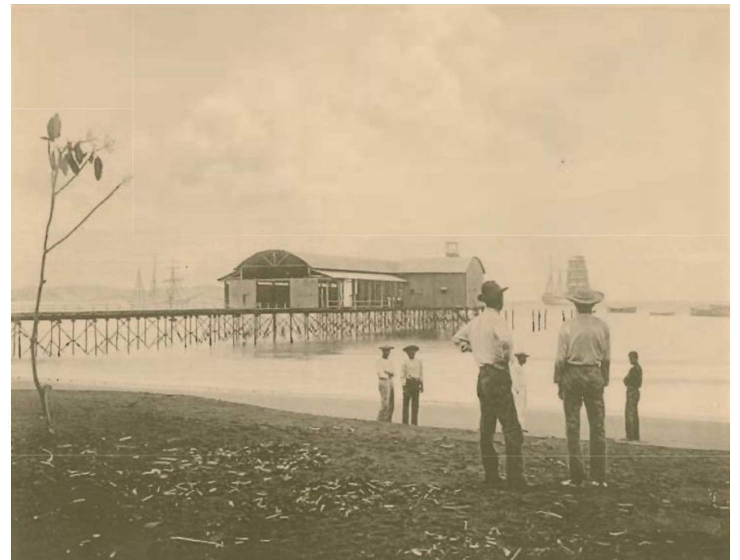
Figura 25. El muelle de Puntarenas (c. 1909) permitió, durante algunos años, aumentar el tráfico marítimo, aunque pronto sus limitaciones de tamaño y profundidad de calado lo harían obsoleto (Fuente: Zamora, 1909)
